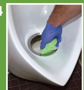
Con el cartucho afuera limpíe dentro del desagüe echando un galón de agua con jabón.
